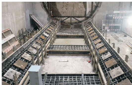
图9 中板始发导台纵梁及联系梁施工
