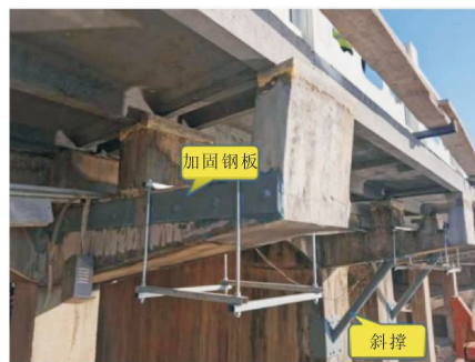
图 11 托梁加固现场照
