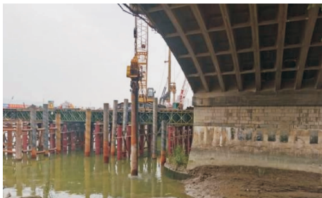
图 3 桥梁现场施工照
