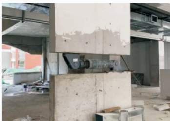
(b) 阻尼器现场布置安装
