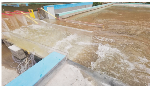
图 7 设计洪水位冲砂闸 + 两边孔泄洪闸全开泄洪消力池及池后水流流态
