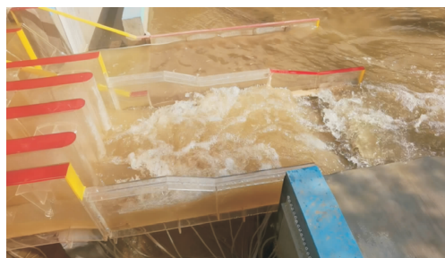
图5 设计洪水位冲砂闸 + 两边孔泄洪闸全开泄洪消力池及池后水流流态
