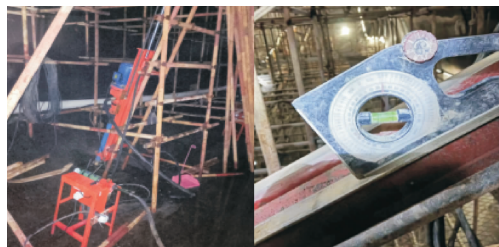
图 6 钻孔孔斜控制过程
