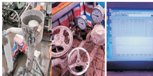
图 7 灌浆压力-注入率控制过程
