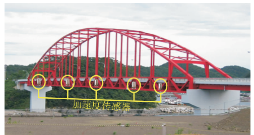
图 1 Kabashima 大桥照片与加速度传感器布设
