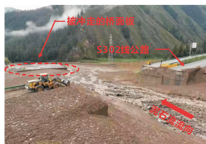
(a) 深水槽大桥被泥石流冲毁
