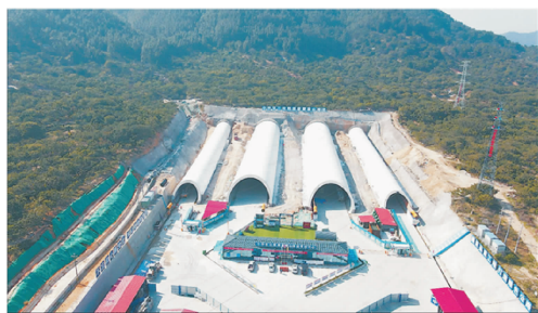
图 1 董奉山隧道入口段地貌实景图
