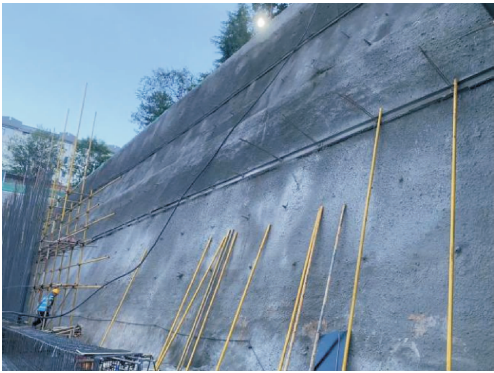
图 11 工程复合土钉墙施工效果图
