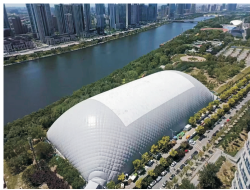
图 1 通州玉带河大街基坑气膜外观
