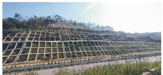
(a) 运行路堑边坡
