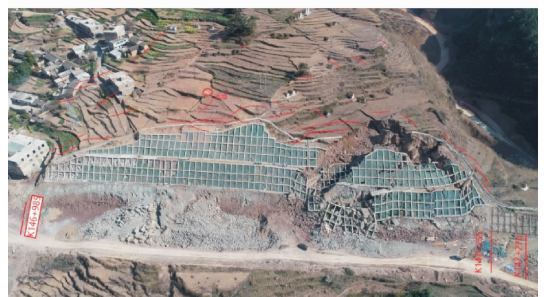
(c) 在建路堑边坡
