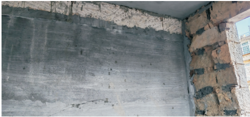
图 12 UHP-ECC 面层加固
