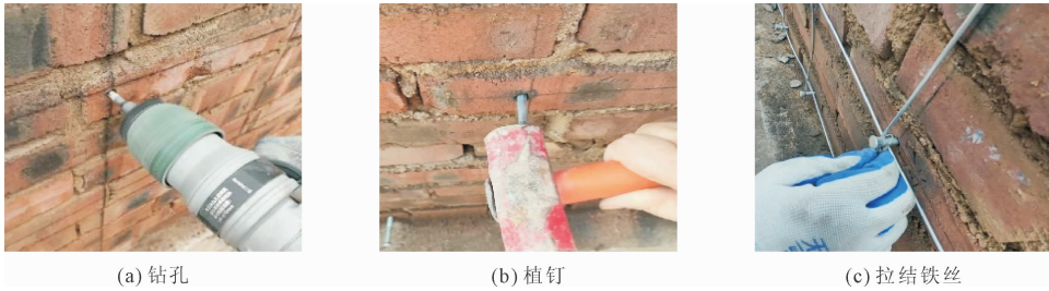
图 11 界面构造措施施工
