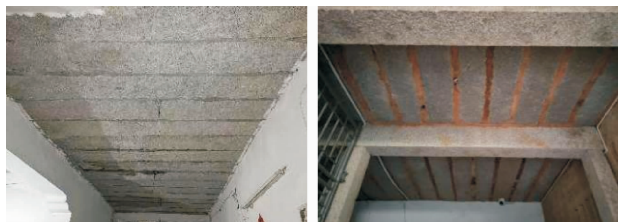
图1 石结构民宅房屋石板
