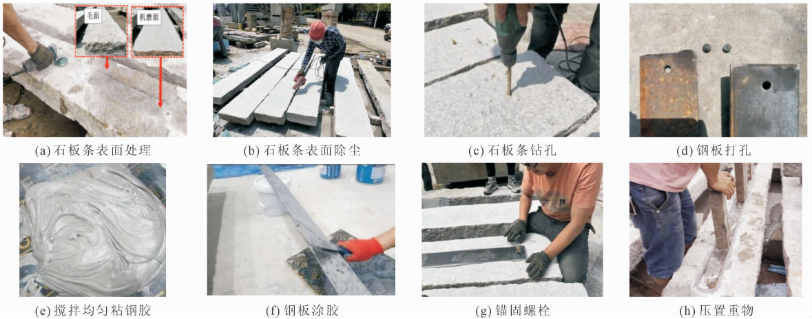
图 3 试验试件加固施工过程
