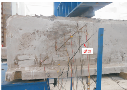
图 6 未加固空心板破坏照片
