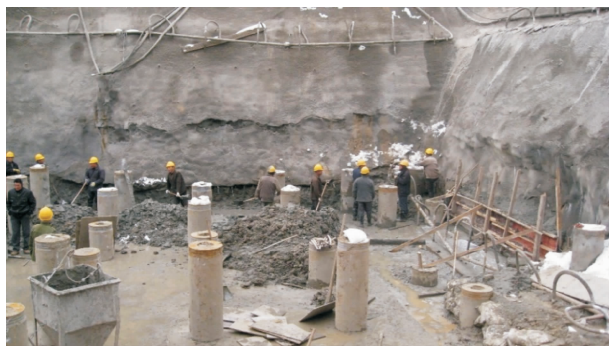
图 2 基坑轻型井点降水现场图片
