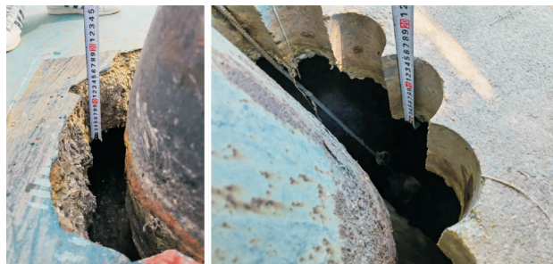
图 5 生物反应池廊道及粗格栅前池的混凝土顶板厚度测量
