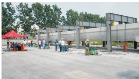
图5 预制U型梁静载测试现场
