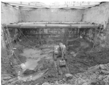
图9 支撑架设情况
