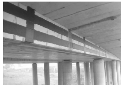
图 5 箱梁腹板碳纤维加固
