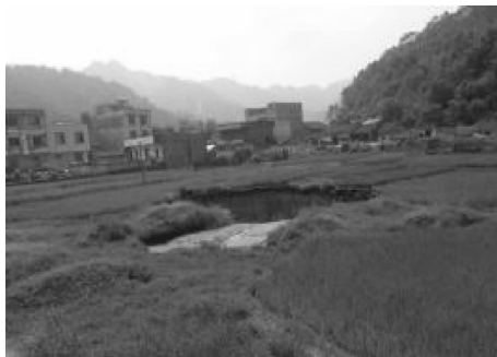
图2 围岩变形引起的地表塌陷
