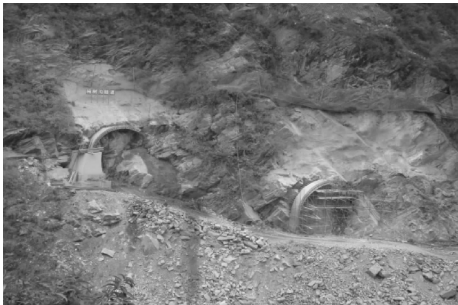
图 5 柿树沟隧道洞口台阶式套拱施工现场
