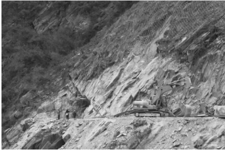
图 3 葦岩隧道洞口施工现场
