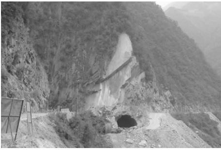
图 2 洞口顺层结构滑塌
