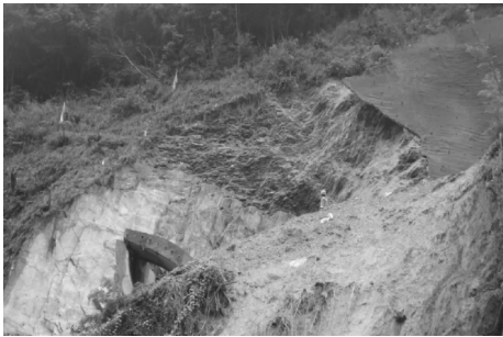
图 1 洞口松散坡积体滑塌
