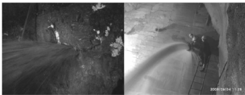
图 2 掌子面溶洞水状况
