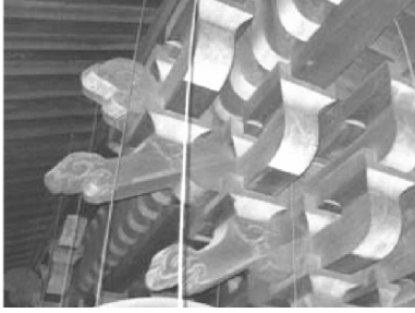
图 8 文献 [57] 提供的日本古建筑斗拱照片
