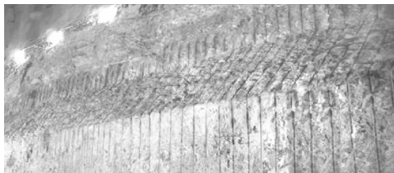
图 2 岩锚梁台及直立墙成型效果
