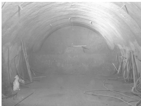
图 3 辐射井降水施工完成后效果图
