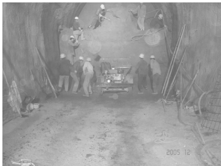
图 4 辐射井降水完成后隧道开挖
