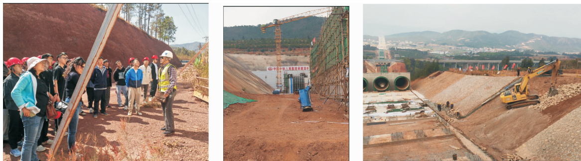
图 1 参观滇中引水工程施工现场
