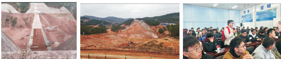
图 2 参观水库施工现场,和行业专家交流
