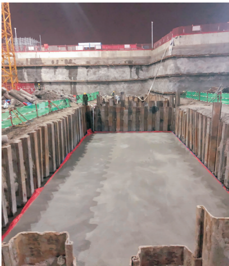
图 10 钢板桩隔水实施效果
