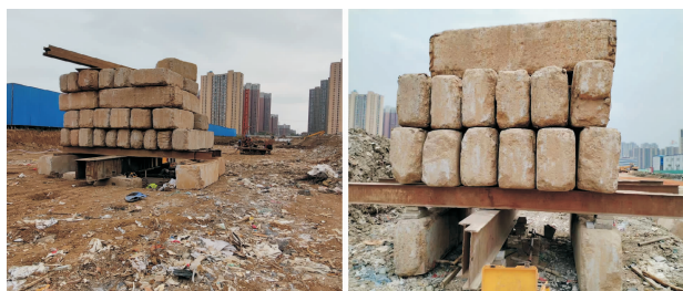
图 5 现场载荷板试验照片
