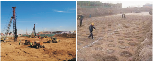
图4 素土(灰土)挤密桩施工现场
