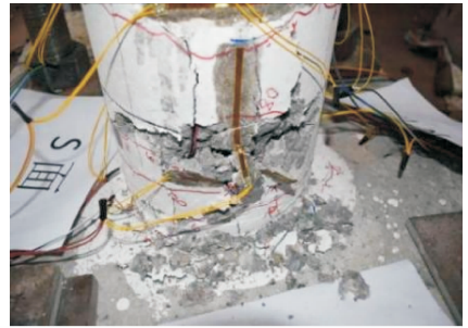
(a) 柱底E面破坏
