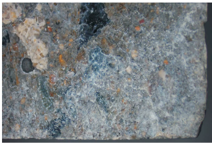
(a) 混凝土断面1
