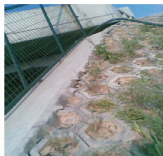
图 2 边坡裂缝
