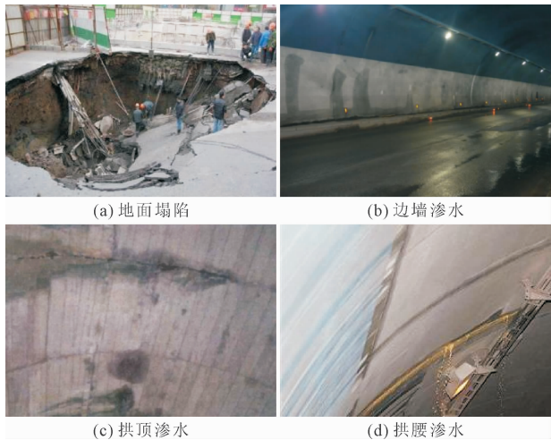
图 1 临近地铁水环境变化诱发的灾害问题
