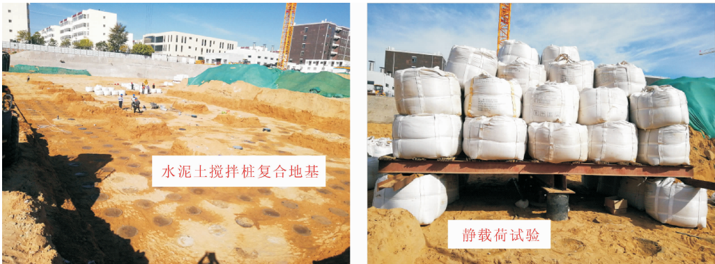
图 2 水泥土搅拌桩复合地基静载荷试验
