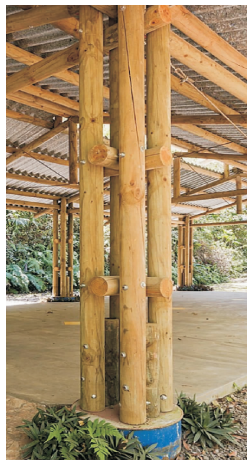
图1 圆形肢件格构木柱
