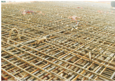
图 6 整体化铺装层钢筋布置照片
