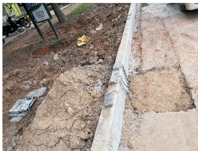
图 2 土压力盒埋设试坑
