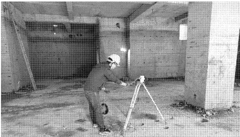
图 8 磁测井法现场测试
