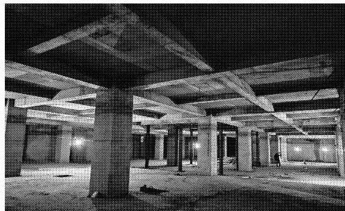
图 2 福州商贸大厦地下室
