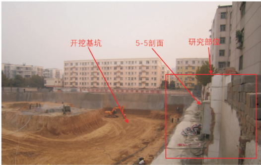
图1 基坑工程现场
