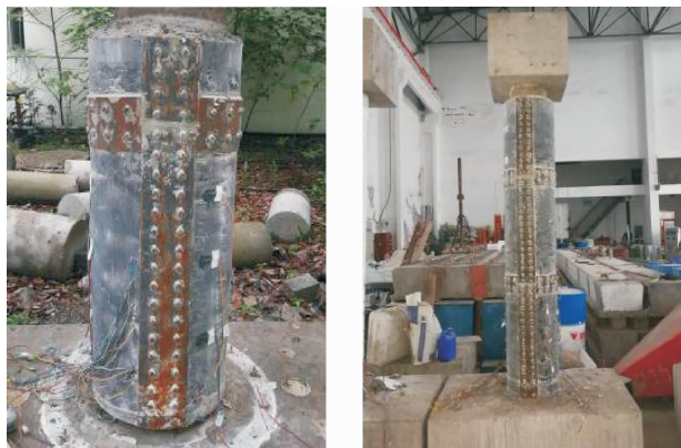
图 3 BFRP 模壳加固墩柱
