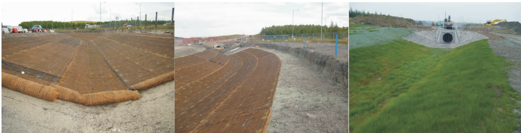
图 4 植物纤维毯河床护底示例(英国 英格兰约克郡 威弗利煤矿生态恢复工程)
