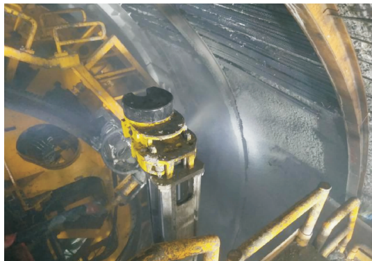
图9 L1 区喷浆机械手作业
