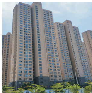
(c) 框架剪力墙结构住宅
