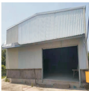
(b) 钢结构单层厂房
