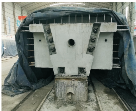
图3 养护后的混凝土箱梁
