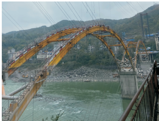
图 6 钢管混凝土拱肋打开前
