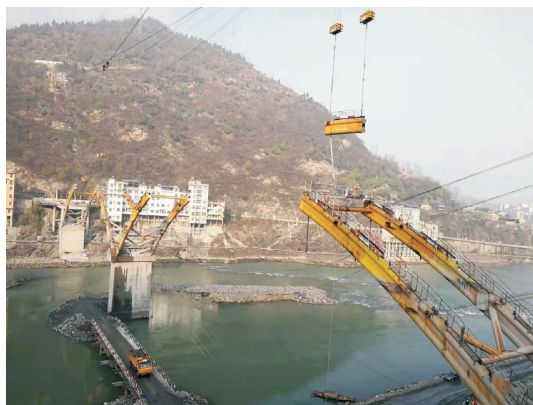
图 7 钢管混凝土拱肋节段拆除
