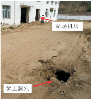
图1 黄土暗穴在车辆压陷后暴露出来
