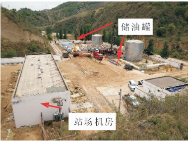
图 13 某站场典型的构筑物
