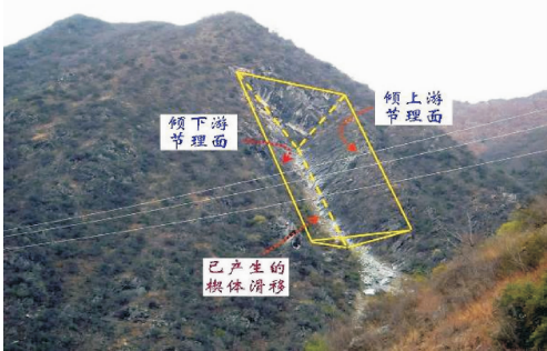
(b) 倾外结构面控制的右岸边坡变形破坏
