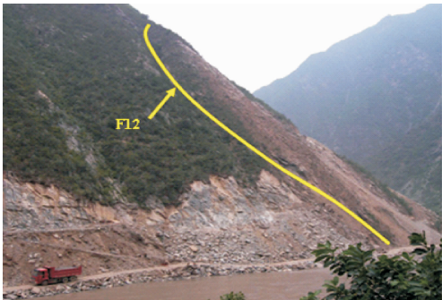
(a) 左岸顺层状同向岸坡结构滑移
