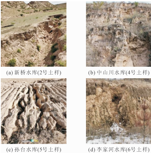
图 1 部分水库土料场冲蚀调查照片
