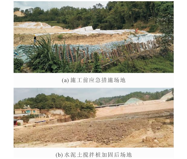
图 7 K59 + 320 弃渣场临时和永久加固场地概貌
