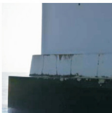
图 5 杭州湾大桥 D13 墩柱
